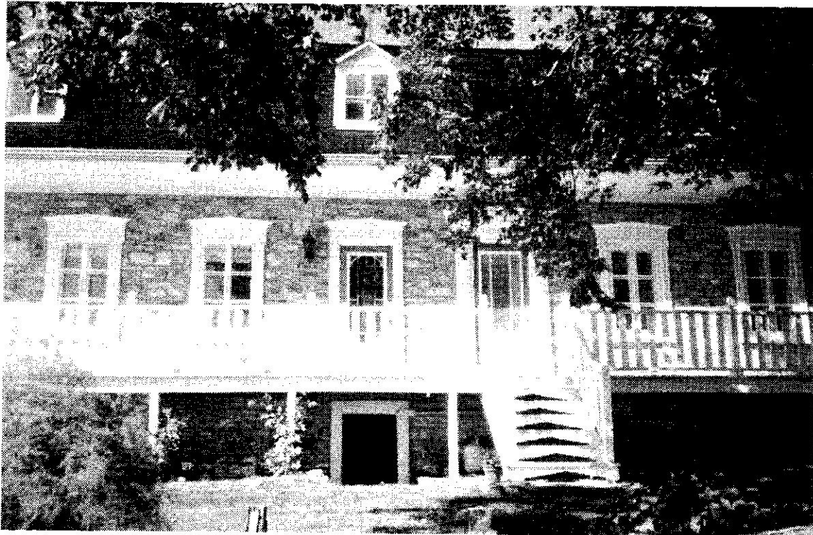
Façade de la maison Thomas Simard érigée sur le site de la maison de Robert Caron et de Marie Crevet détruite par un incendie.
